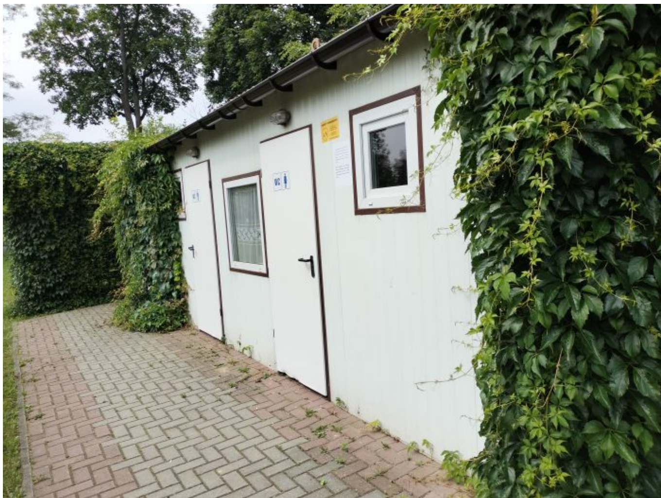
Toalety przy ulicy Parkowej
