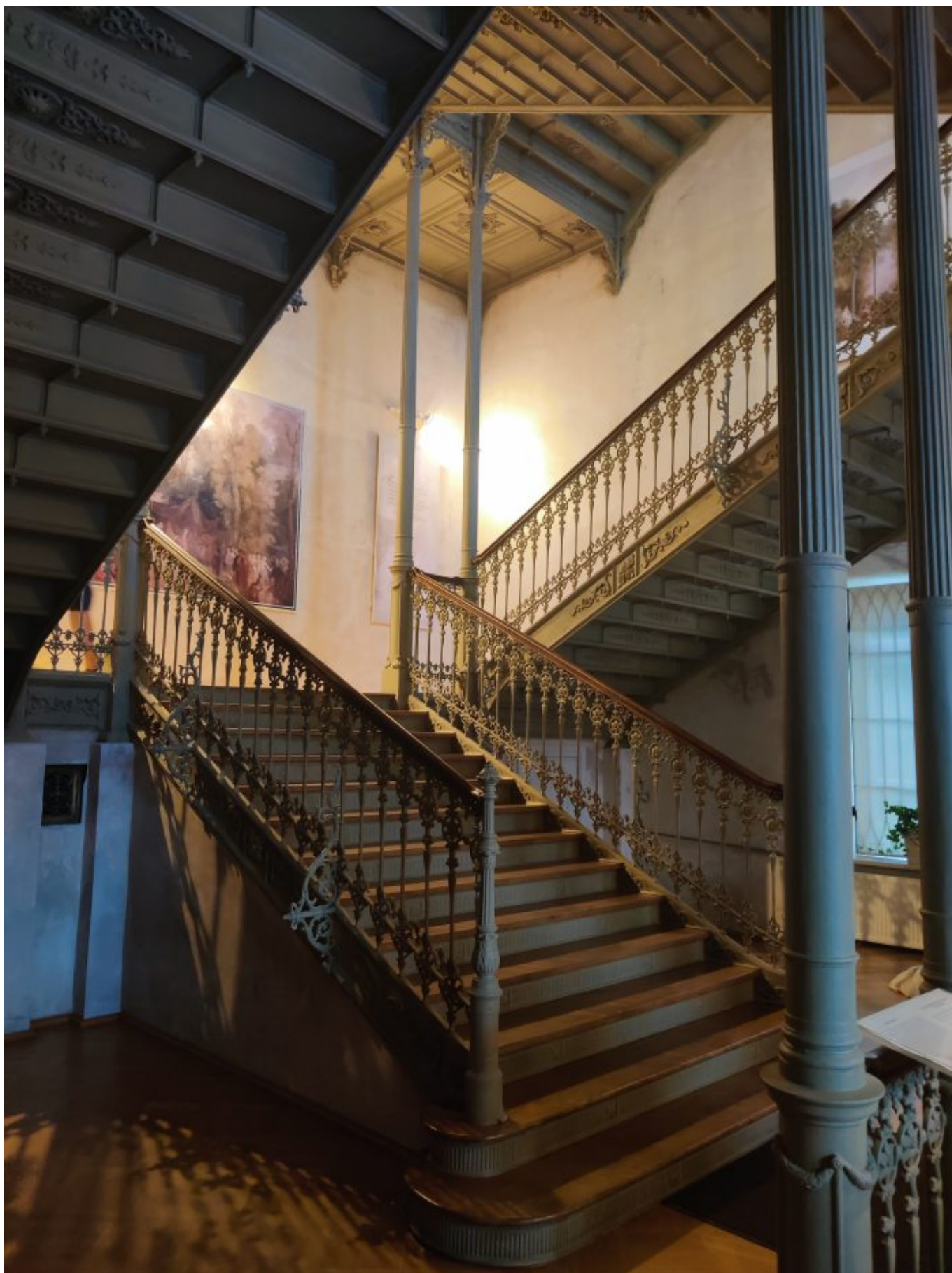
Wejście klatką schodową na górne piętra
